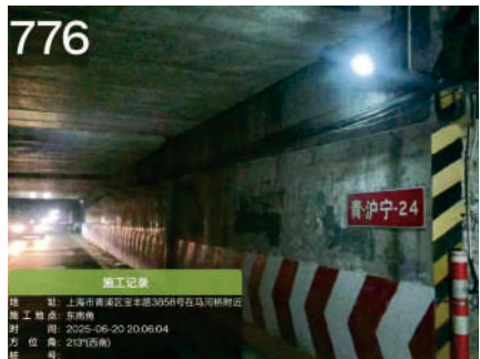
▲ 马桥立交桥洞内两侧已安装太阳能路灯
